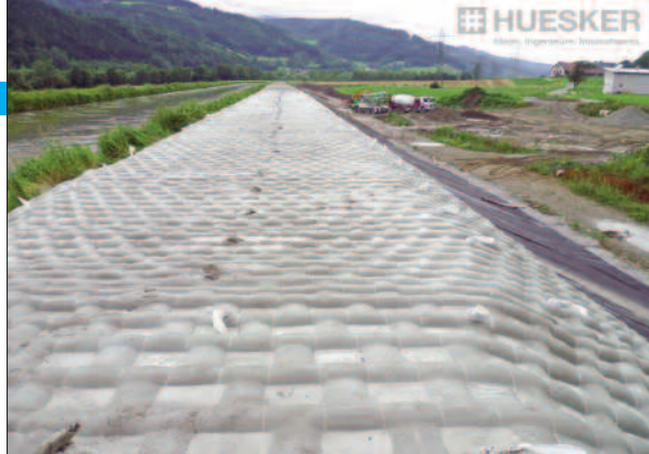
Die Incomat® Betonmatte sichert den Dammabschnitt vor Erosionsschäden
