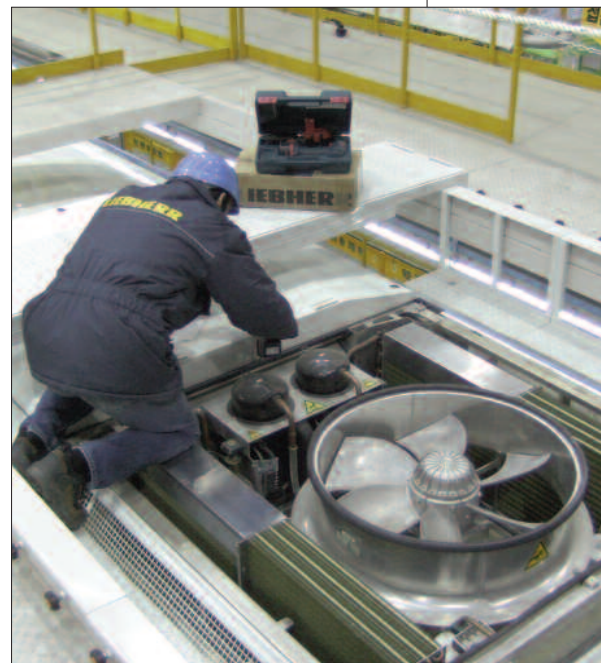
Vorbereitung einer Klimaanlage beim Kunden
