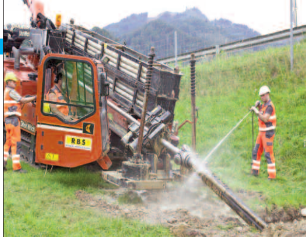
Spülbohranlage Ditch Witch JT100 – erfolgreicher Rohreinzug – Bohrlänge 235 lfm
